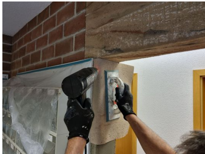
Abbildung 8: Um die Ecke kleben
