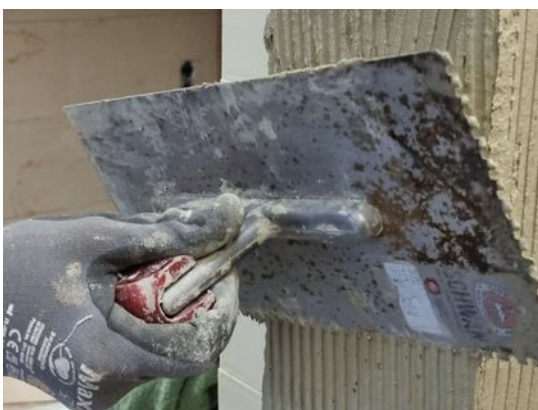
Abbildung 4: Kleber auftragen
